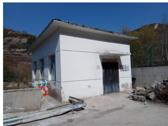
消防加压泵房
