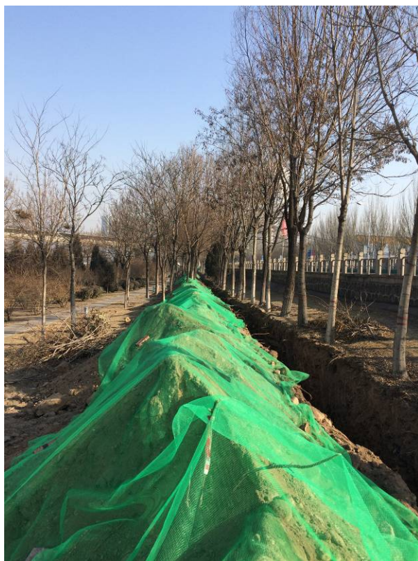
施工过程中苫盖措施
