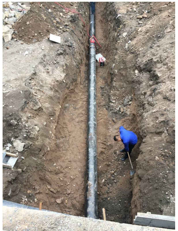
管道防腐照片
