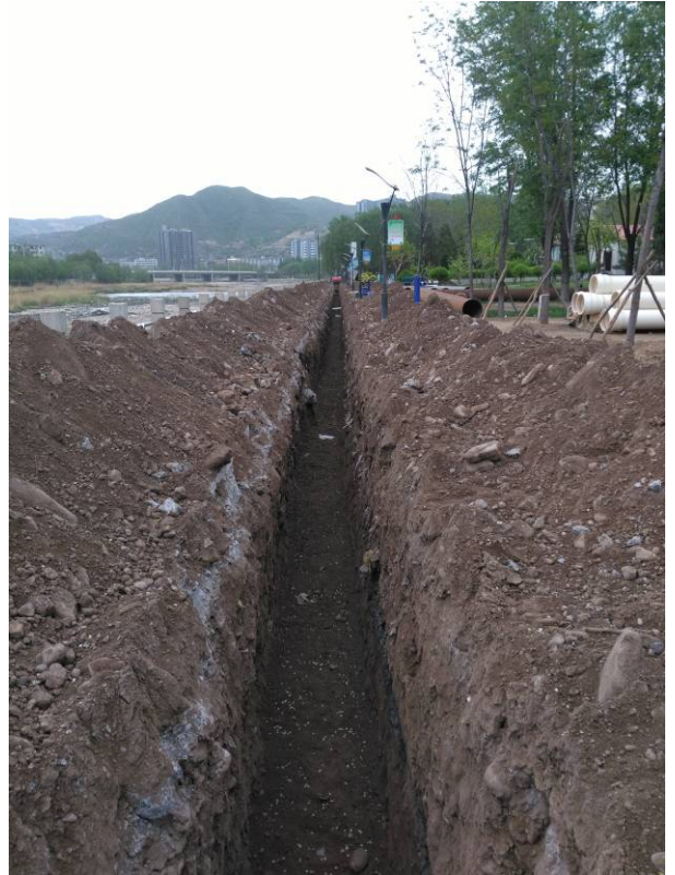
施工过程照片
