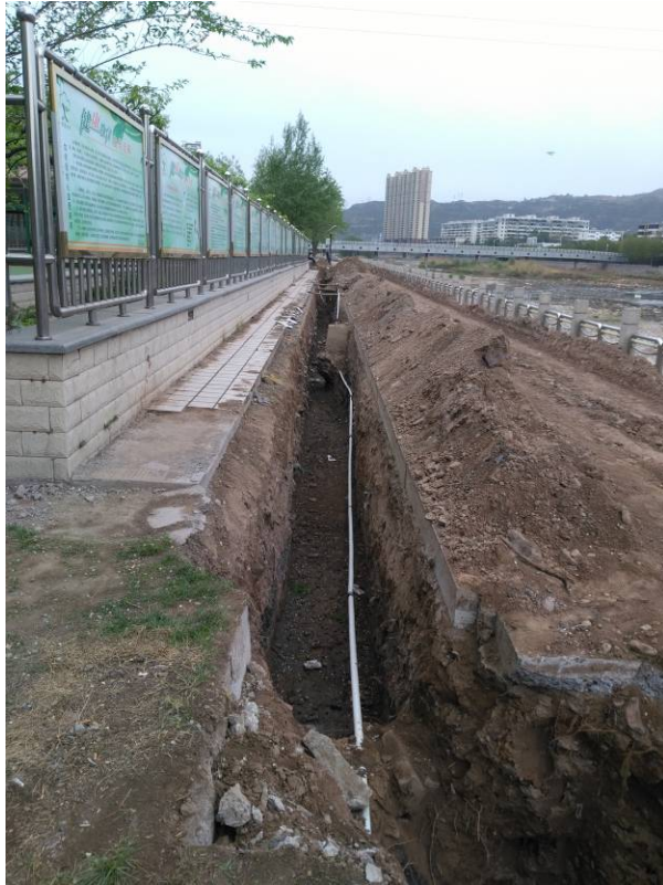
施工过程照片
