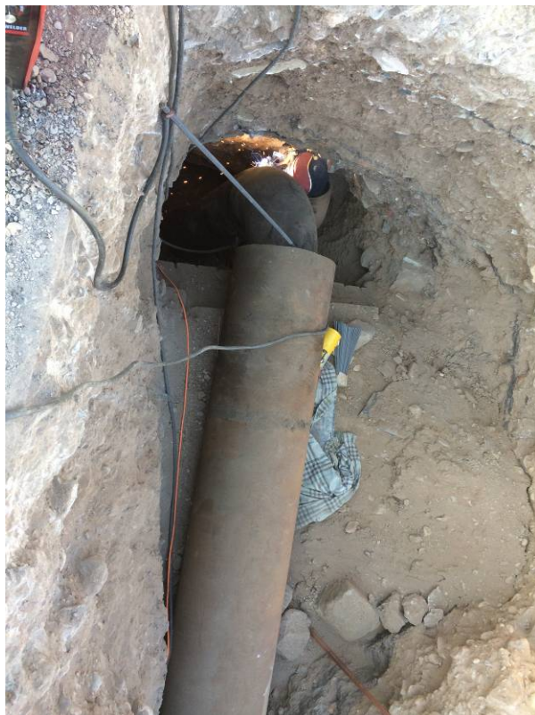
管道套管照片
